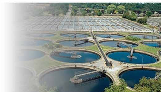
Noticias sobre Aguas Residuales
